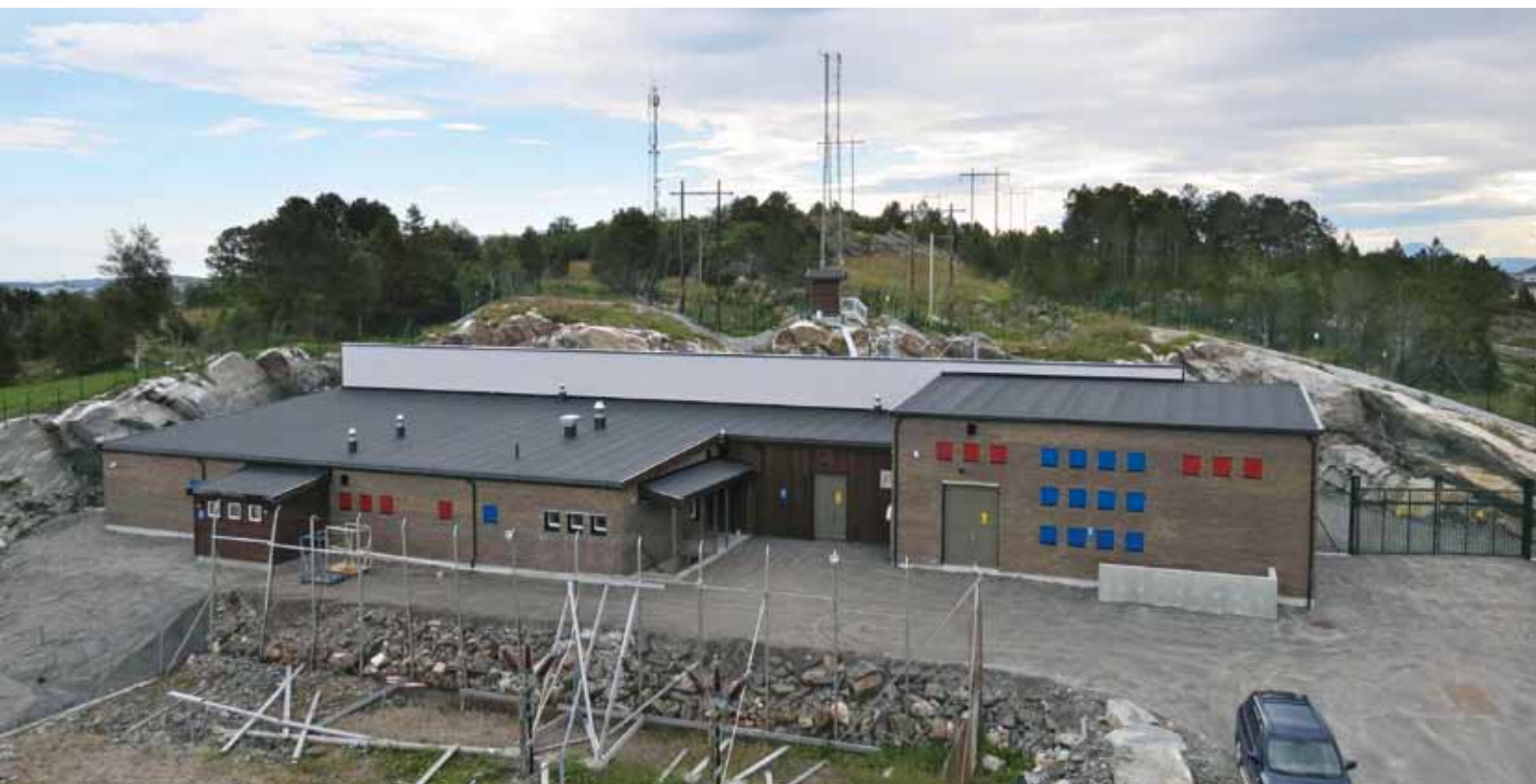
Nye Nordlandet transformatorstasjon, satt i drift høsten 2014. (Foto: NEAS)
