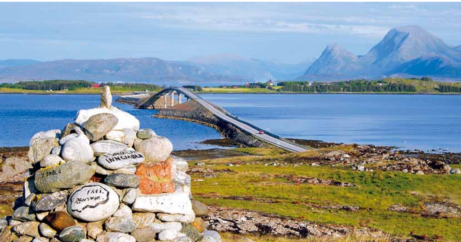
Grønn energi fra vindparken på Smøla transporteres gjennom et nytt ledningsnett på Kulisvaet bru. (Foto: Terje Holm)
