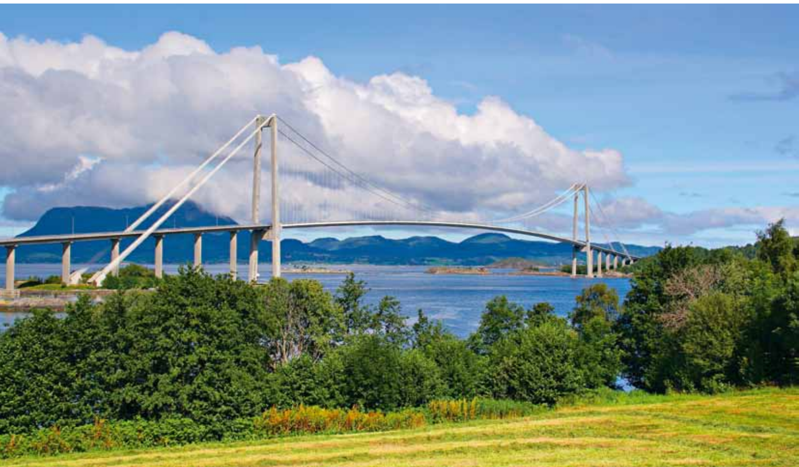
Gjønnessundbrua er en del av E39 med Bergsøya som trafikkknutepunkt. (Foto: Terje Holm)
